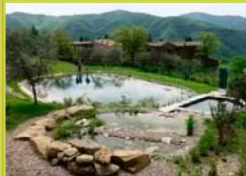
Visione dall'alto di un impianto, si riesce a distinguere chiaramente l'area di depurazione, l'area di balneazione, di rigenerazione e la zona bambini che è separata dall'impianto da un passaggio in pietra naturale. Separazione tra l'area di rigenerazione e l'area di balneazione.
